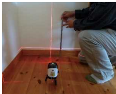
「床の傾きを計測する」調査機器
