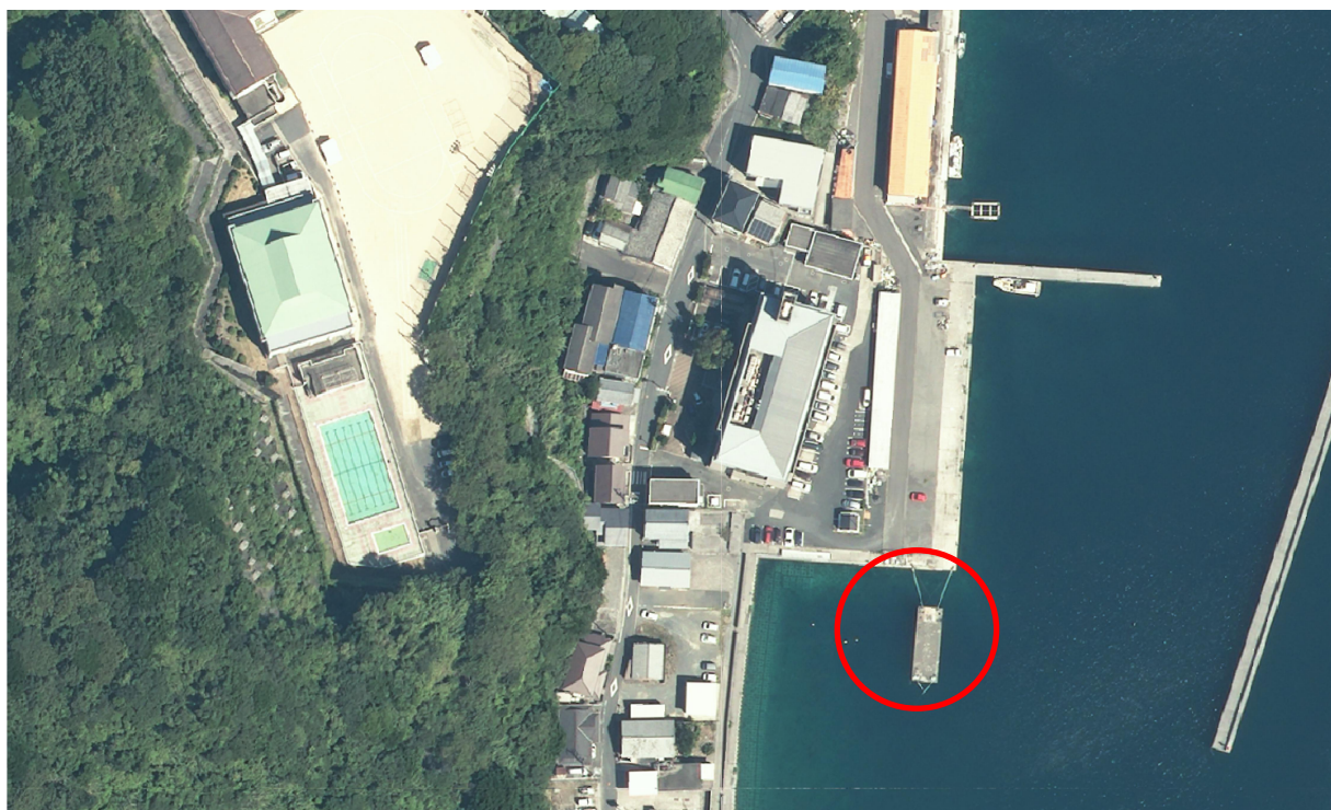
西海支所裏 浮棧橋
