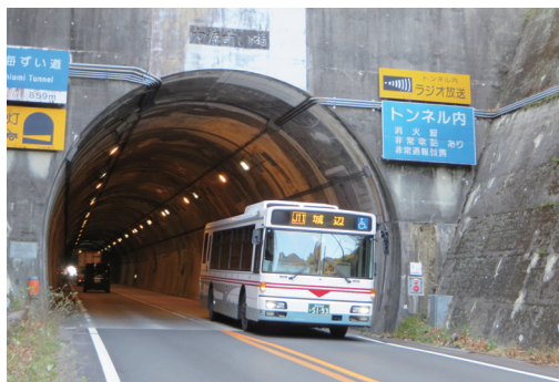
「内海ずい道・トンネルを抜けて」 宇和島バス
