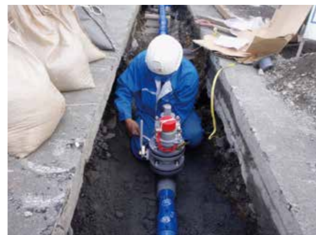
管路の耐震化
