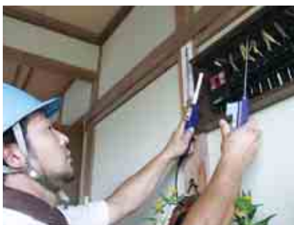
夏場の電気事故を防止しようと、8月の「電気使用安全月間」に合わせて南宇和電気工事組合(西崎良文理事長、16業者が加盟)が、一本松地域の独居高齢者10世帯の漏電調査や電気配線の無料点検を行いました。(8/23)
