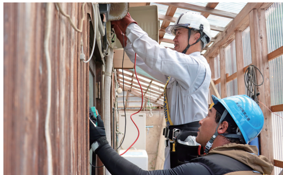
▲配電盤が漏電していないか確認する組合員
