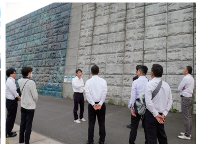
▲雄勝町防波堤
