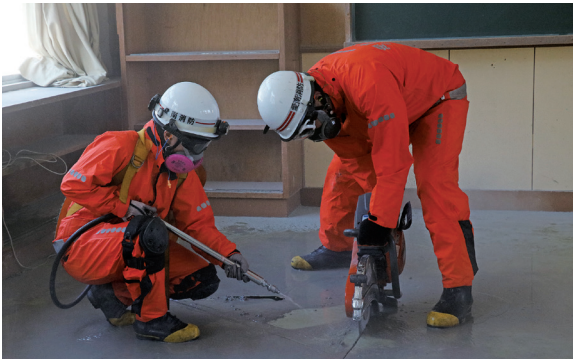
▲エンジンカッターを用いてコンクリート製の床を切断する隊員
