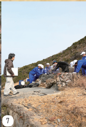
6 爆破により地上に姿を見せた聴音室/7 地面から突き出す通気口は各部屋に設置されていた/8 聴音室内部は鉄筋がむき出しになり、床にはガラスが散乱している
