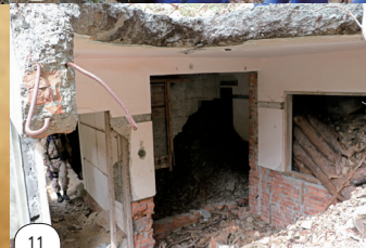
11-12 見張所の壁には迷彩柄の塗装が残る一方、土砂崩れや劣化による損傷が激しい
