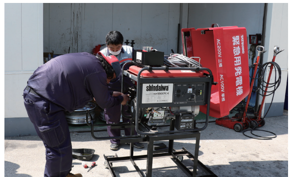
▲緊急用発電機を点検し、稼働させる給油所のスタッフ
