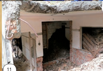
9-10 兵舎跡には炊事場の跡も見られ、地面には当時の物と思われる瓶が転がる 11-12 見張所の壁には迷彩柄の塗装が残る一方、土砂崩れや劣化による損傷が激しい
