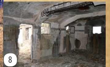
6 爆破により地上に姿を見せた聴音室/7_地面から突き出す通気口は各部屋に設置されていた/8_聴音室内部は鉄筋がむき出しになり、床にはガラスが散乱している
