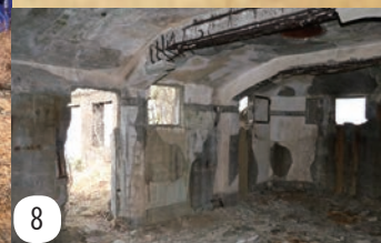
6 爆破により地上に姿を見せた聴音室/7 地面から突き出す通気口は各部屋に設置されていた/8 聴音室内部は鉄筋がむき出しになり、床にはガラスが散乱している
