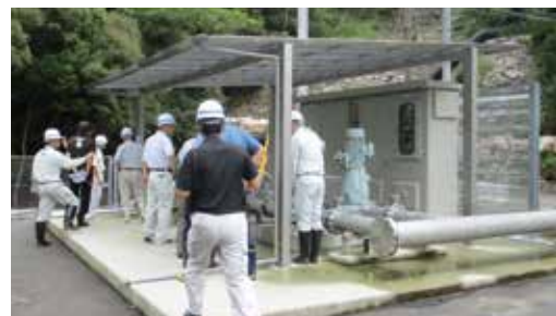
【小水力発電施設視察風景】
