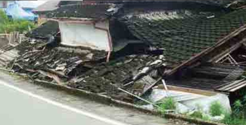
熊本地震被災家屋
